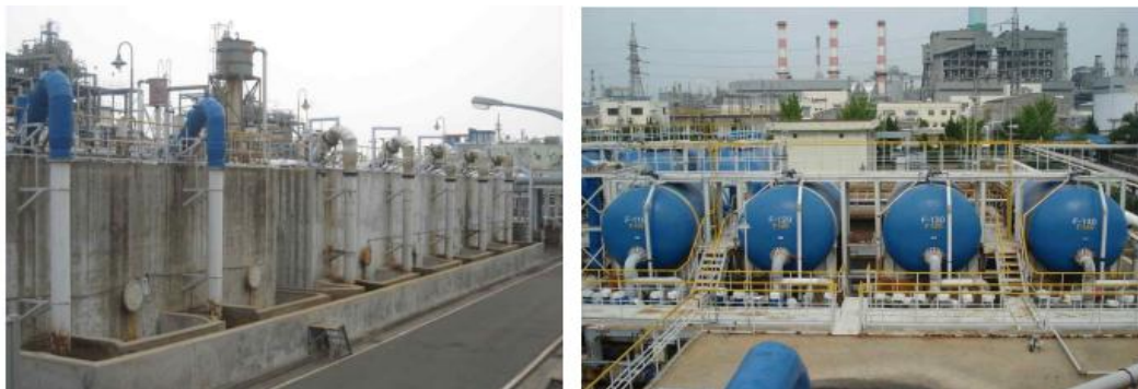
< 그림 8 > 중력식 여과 장치 및 가압식 여과 장치
